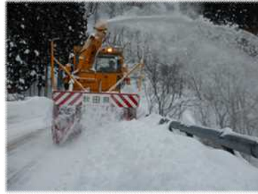
冬期の安全な交通を確保する道路除雪作業
