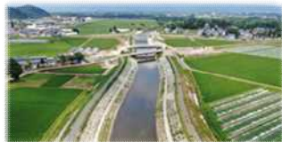
洪水被害が発生した河川の改良復旧
