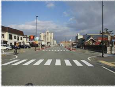
街路整備・無電柱化による道路環境の改善
