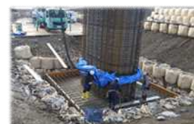
橋梁の耐震補強工事
