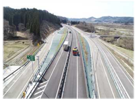
日本海沿岸東北自動車道 蟹沢IC付近
